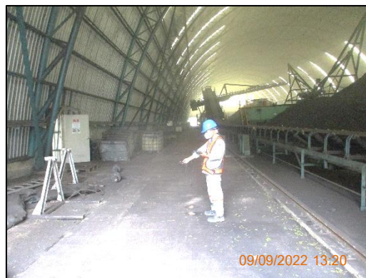
ภาพที่ 3.81 การตรวจวัดระดับความเข้มแสงในสถานที่ทำงาน จุดบริเวณทางเดินในโกดัง
